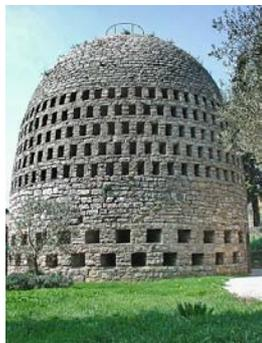
Ce puits aérien est le premier puits de récupération automatique par condensation de l'humidité atmosphérique construit dans le monde.
