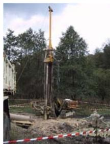
La technique traditionnelle consiste à introduire dans le forage, après nettoyage, de nouveaux équipements (tubage notamment) afin de renforcer la structure existante. Cette méthode est utilisée pour consolider un ouvrage très abîmé et affaibli en plusieurs points du forage. L'ancienne structure est alors « remplacée » par une nouvelle.
