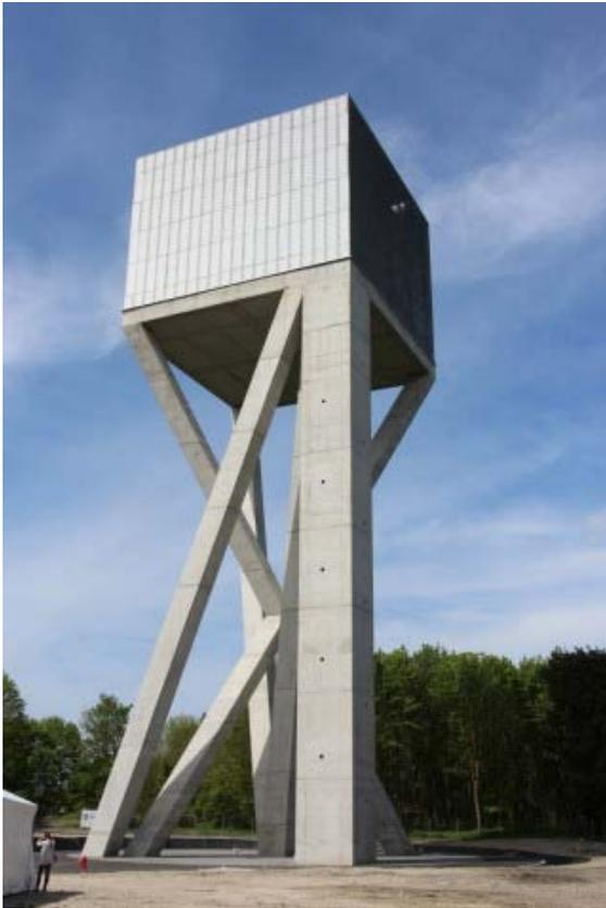
Ce château d'eau d'une hauteur de 52,5 m et d'une capacité de stockage de 2000 m<sup>3</sup> a été conçu par le bureau d'architecture « Vers plus de bien-être » (V+)
