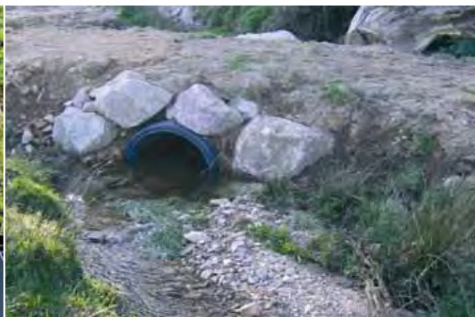
Arche polyéthylène en place sur cours d'eau
