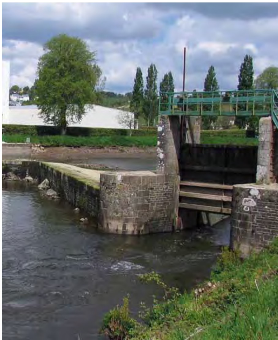
Exemple de gestion d'ouvrage : ouverture de pertuis
