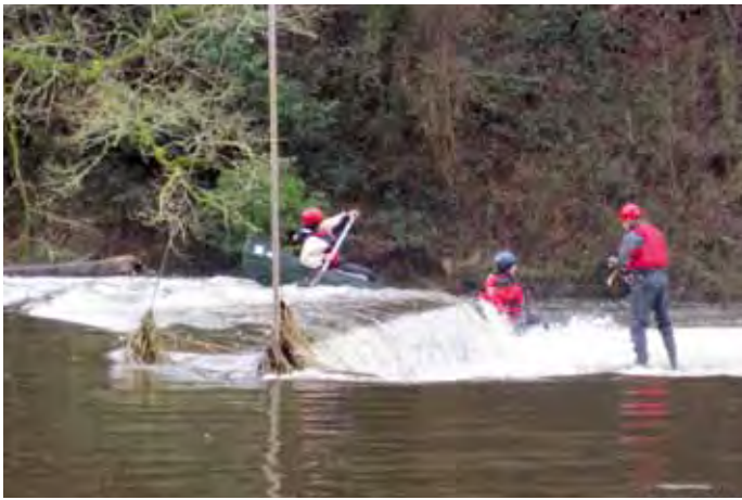
Ouvrage franchissable par les kayaks
