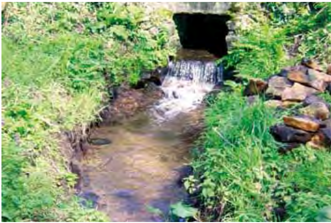
Obstacle avant aménagement
