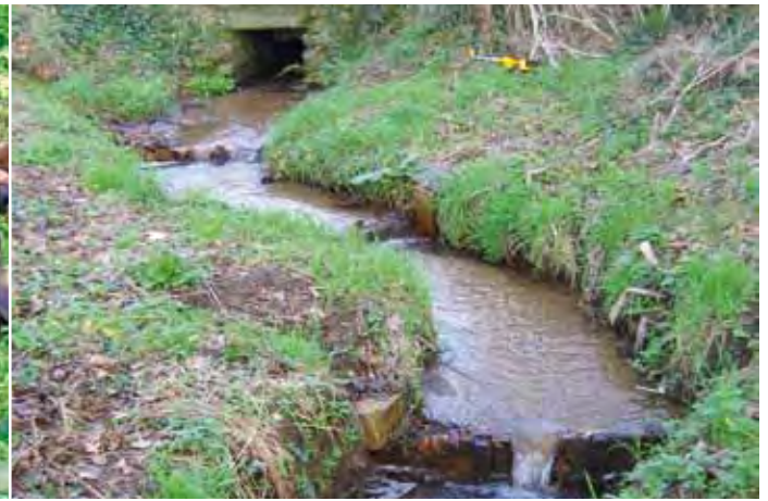
Obstacle aménagé avec pré - barrages en pierre
