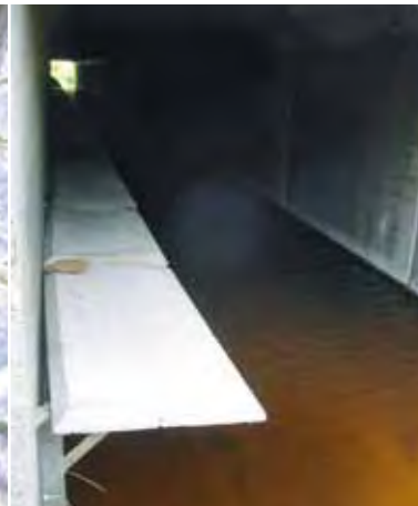
Les passerelles en dalles de béton sont efficaces si ces dernières sont jointives
