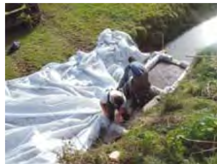
Etanchéification des bassins par géotextile
