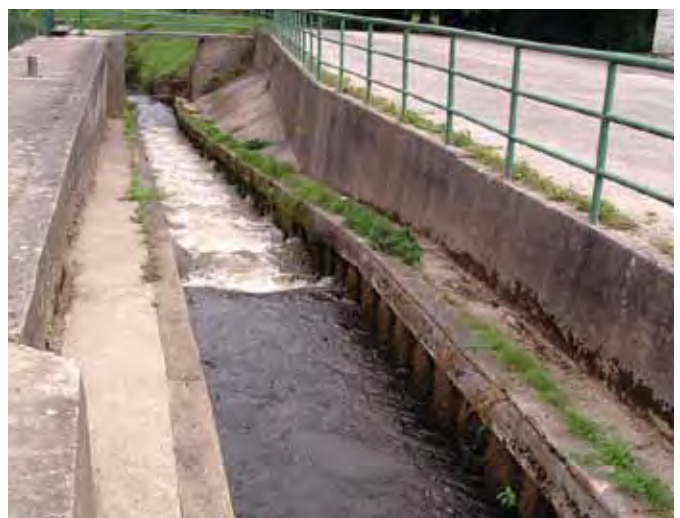
Passe à poissons à bassin
