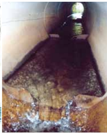
Déflecteurs posés dans une buse
