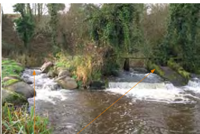
Rivière de contournement - Obstacle Rivière de contournement bien positionnée : sortie proche de l'obstacle
