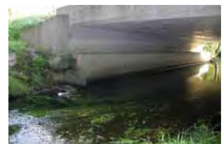
Ci-dessus, banquette le long du cours d'eau
